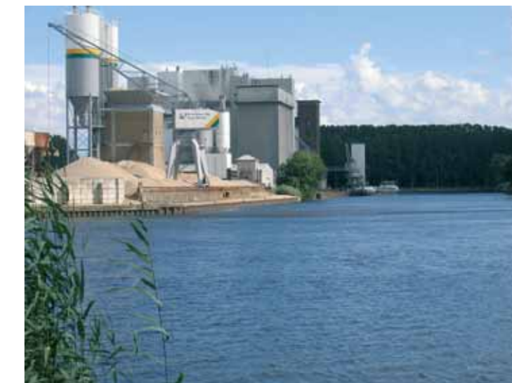
De eerste havenarm aan het Twentekanaal: zand en veevoer.
