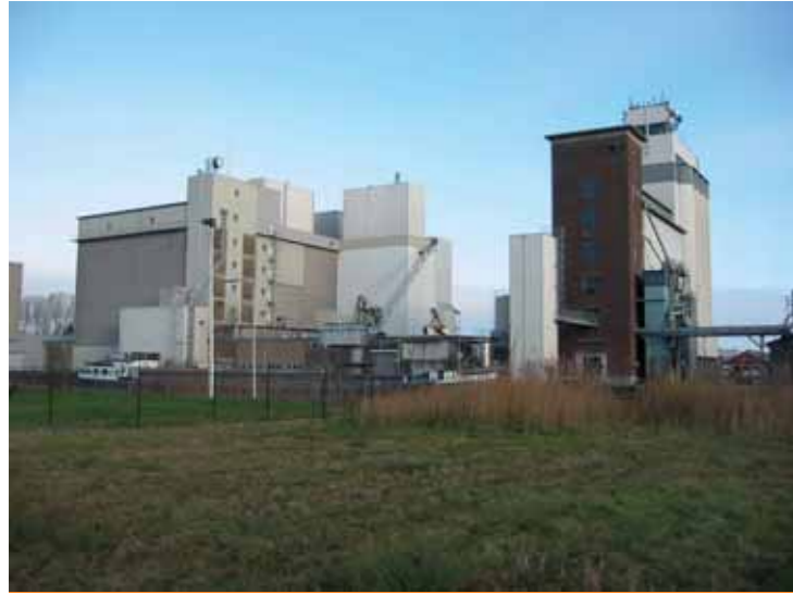
De hoge bakstenen CVT silo was één van de eerste gebouwen van Dollegoor en vanaf het begin een herkenbaar baken.
