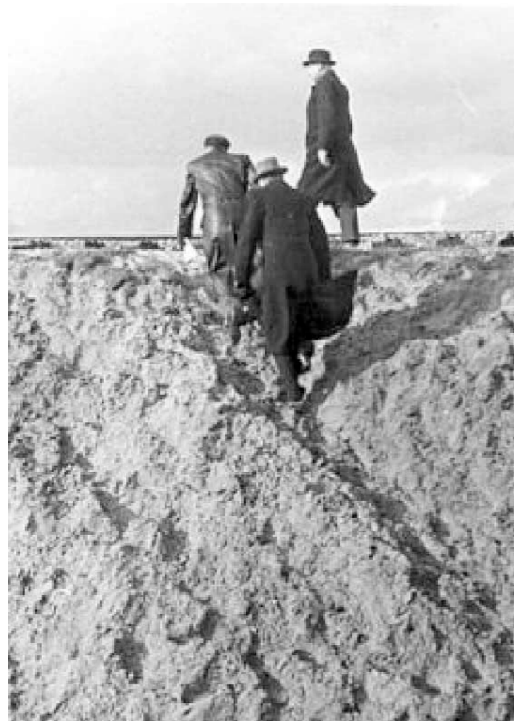
De Commissaris van de Koningin bezoekt de aanleg van industrieterrein Dollegoor, omstreeks 1949-1953. Voor de aanleg van nieuwe industrieterreinen was vaak politieke en bestuurlijke slagvaardigheid nodig. (foto Gemeentearchief Almelo, Dollegoor)
