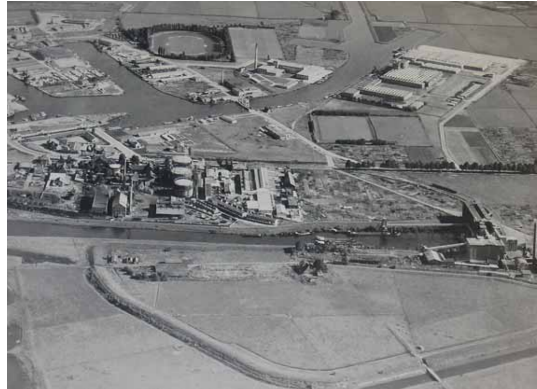
Luchtfoto omstreeks 1956, rechtsboven de Nefit naast Thomassen en Drijver (foto uit: 'Deventer vanuit de lucht, 1924-1959')
