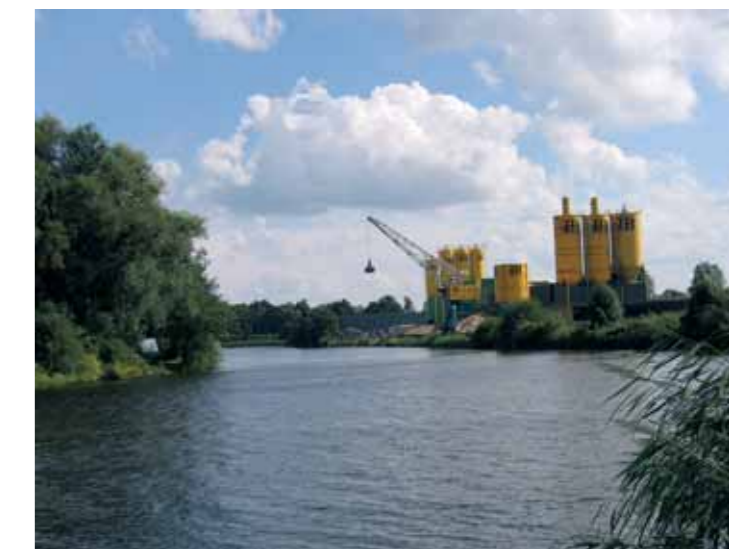
De tweede havenarm aan het Twentekanaal: beton.
